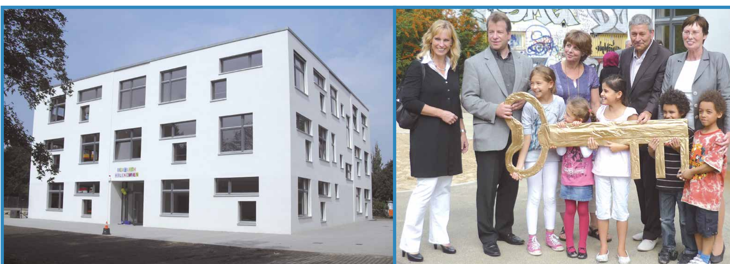
Erweiterungsbau Chamisso-Grundschule und feierliche Schlüsselübergabe, August 2011
