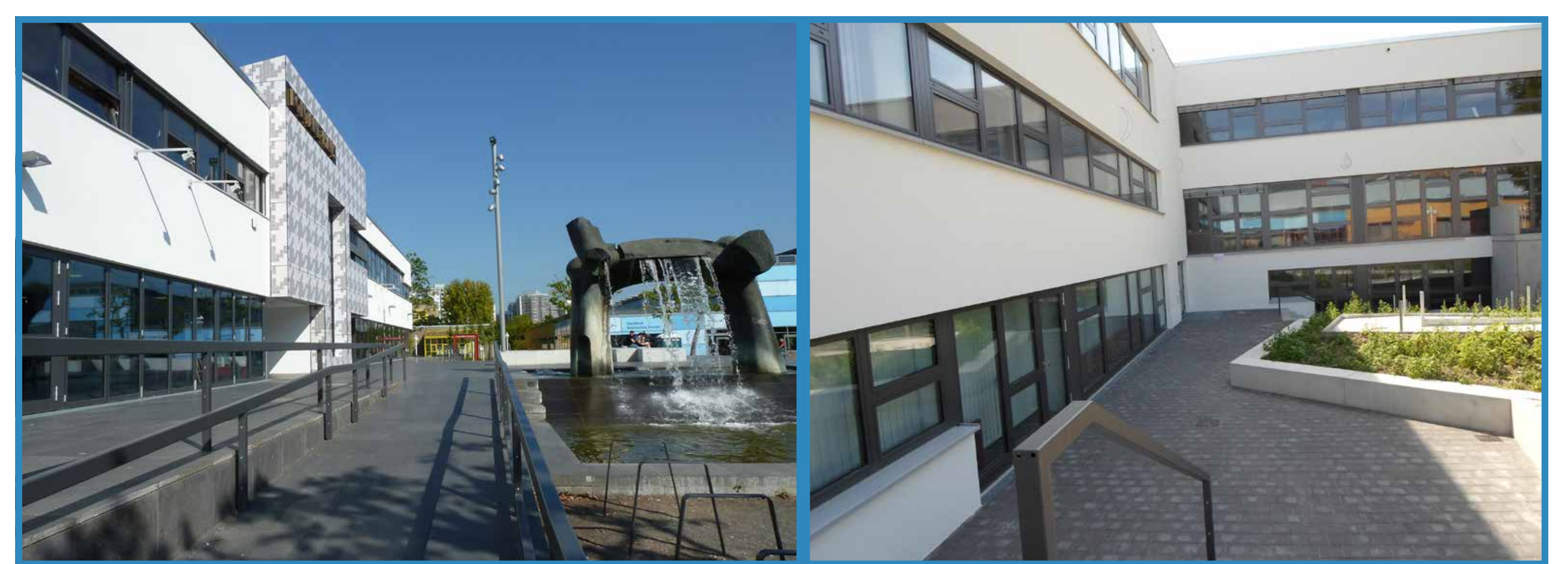
Flachere Rampenanlage für den barrierearmen Zugang
