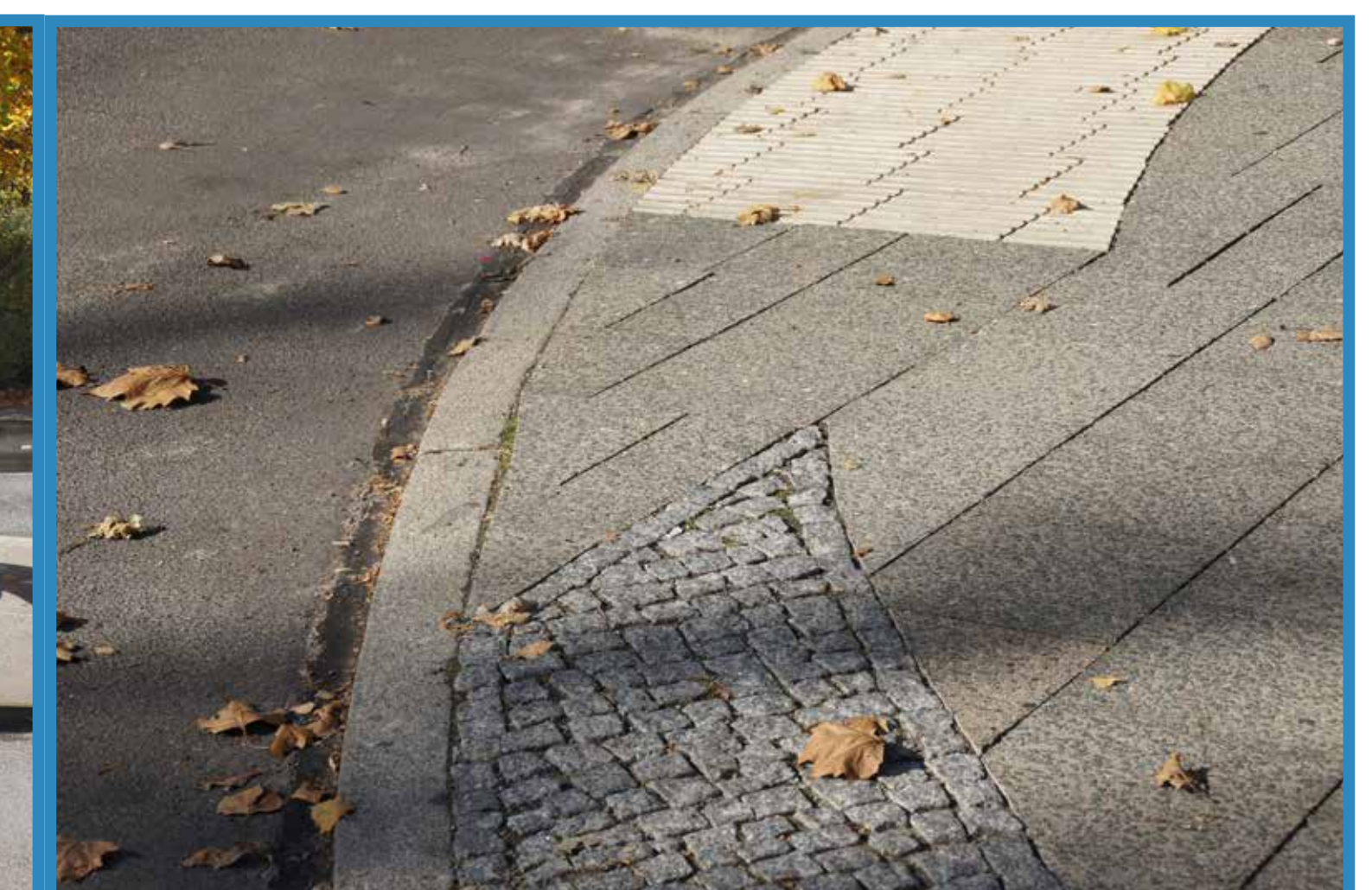
Bordsteinabsenkung Quickborner Straße / Zerpenschleusener Ring
